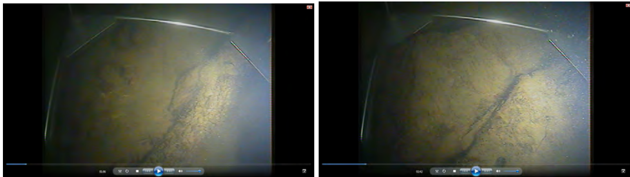
Figur 11 Videobilder av botten vid stolpe 1 (vänster) och stolpe 2 (höger). Stolpe (pollare) 1 ligger längst nordostvart på nya kajen. Stålrampen som syns i bilden är 100x100 cm.
